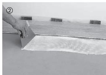
② Kleber vor Gebrauch umrühren. Mit Zahnpachtel auftragen, Auftragsmenge ca. 800 – 1000 g/m<sup>2</sup>. Elemente innerhalb von 15 Min. einlegen.
