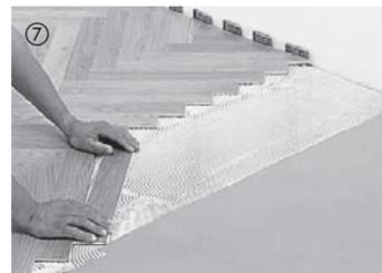
⑦ Von der Mitte aus links und rechts reihenweise bis zur Wand weiterverlegen.
