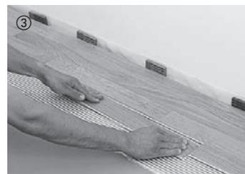
③ Die Elemente werden direkt aus dem Paket entnommen und in Nut und Feder zusammengefügt.
