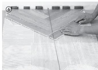
⑥ Erste Fischgrätdoppelreihe entlang der Richtschnur verkleben und auf beiden Seiten bis zur Wand verlegen.
