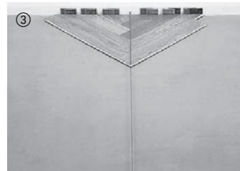
③ Einige Doppelreihen ohne Klebstoff auslegen und zusammenfügen. Die Richtschnur (Mitte des Bildes) verläuft durch die Raummitte.
