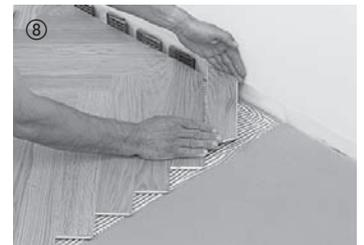
⑧ Im Wandbereich Restelemente mit 45° Sägeschnitt einpassen (umlaufend Wandabstand von ca. 10 mm einplanen). In Türübergängen kann ohne Dehnungsabstand verlegt werden.
