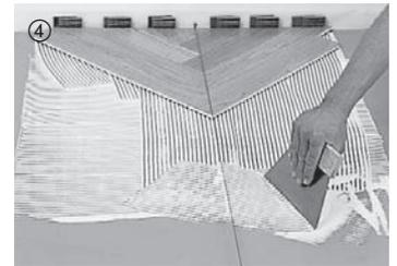
④ Klebstoff entlang der mittig ausgelegten Richtschnur auftragen. Die vorab ausgelegten und zusammen gefügte Elemente in das Klebebett einlegen. Nur soviel Klebstoff auftragen, wie in 15 Min. Stäbe verlegt werden können (Auftragsmenge 800 – 1000 mg/m<sup>2</sup>).
